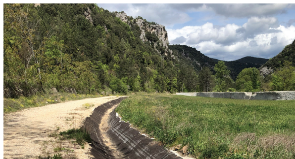
Réaménagement des bassins avec fossé étanché en géomembrane.
