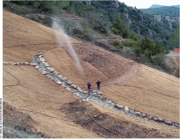
Semis hydrauliques des talus recouverts de géofilet en fibres de coco, après installation du réseau d'arrosage.
