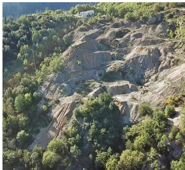
Figure 1 : photo prise par drone avant le réaménagement.
