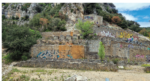
Les ruines de l'ancienne usine et leur mise en sécurité
