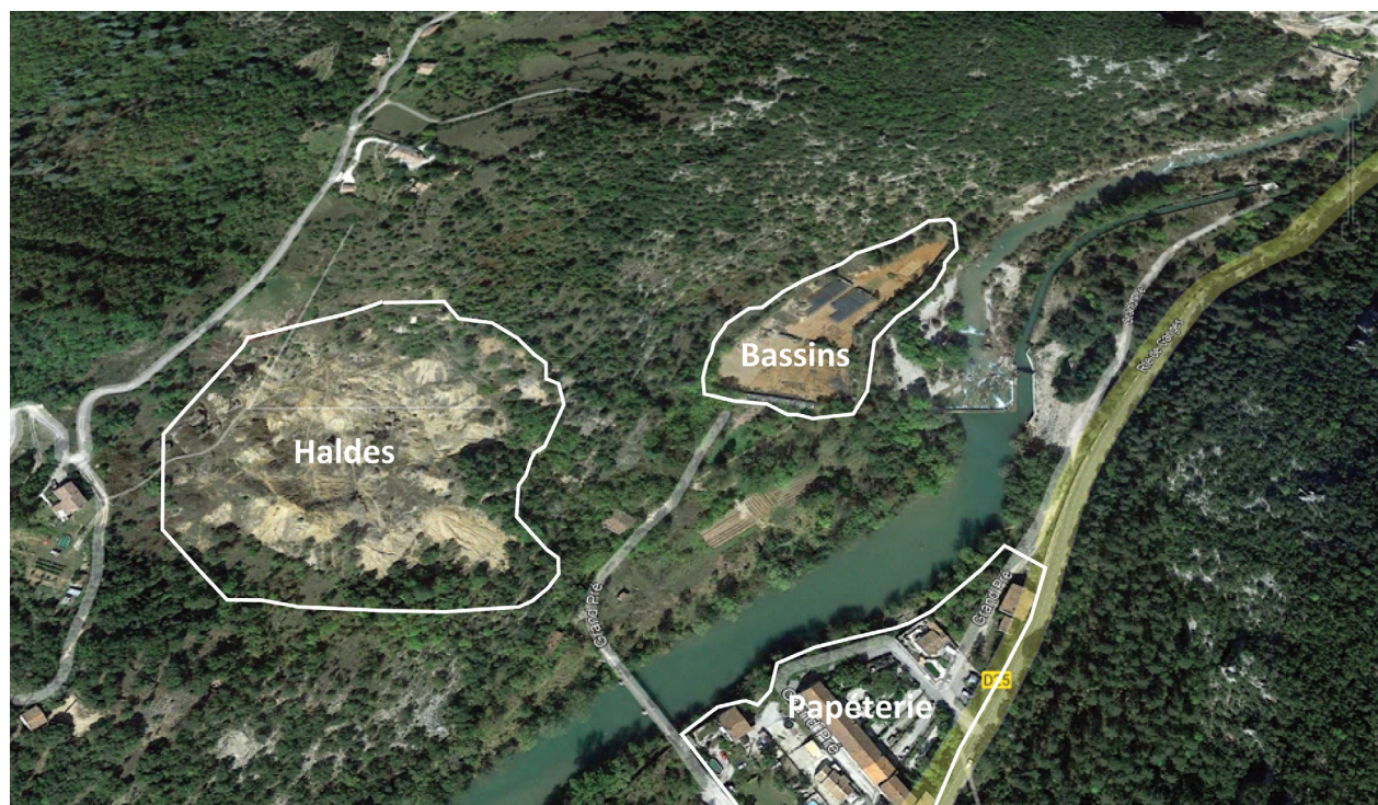
Figure 1 : vue aérienne du site des Avinières avant travaux de réhabilitation.
