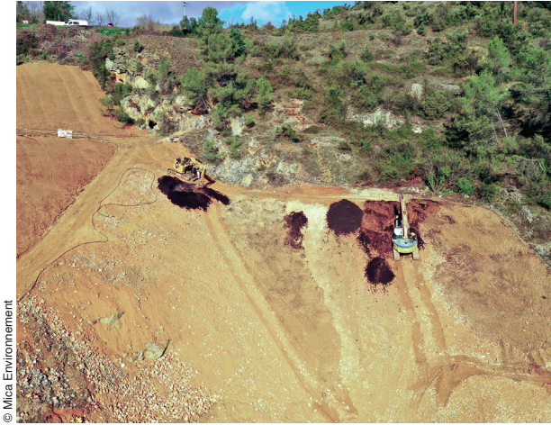
Terrassement et amendement en compost des stériles miniers.
