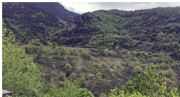
La digue à stérile du site des Malines.
