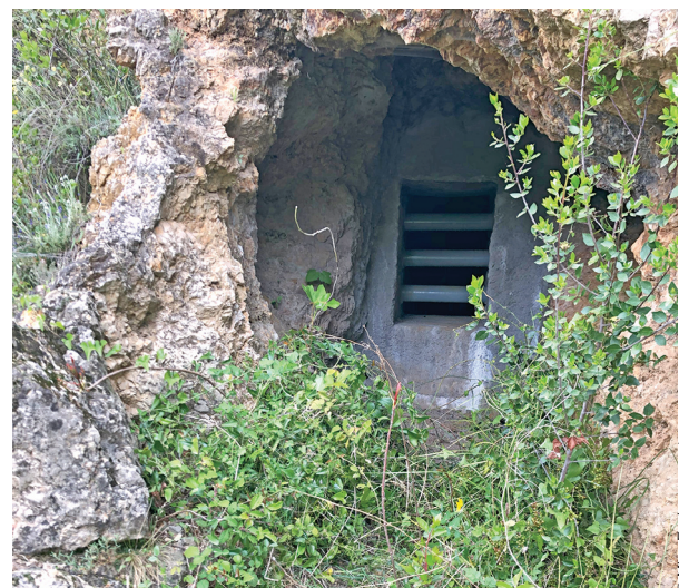
Une galerie encore visible et mise en sécurité.
