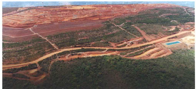
Figure 12 – Exemple de verse de latérites végétalisées par transport de top soil en vrac sur une mine de Nickel en Nouvelle-Calédonie - Conception du réaménagement par Mica Environnement.
