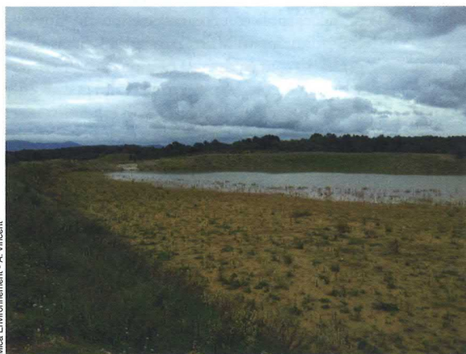
Figure 4 – Bassins à pentes douces, ouvrages de gestion des eaux en matériaux naturels permettent d'accroître la biodiversité (batraciens, lézards).
