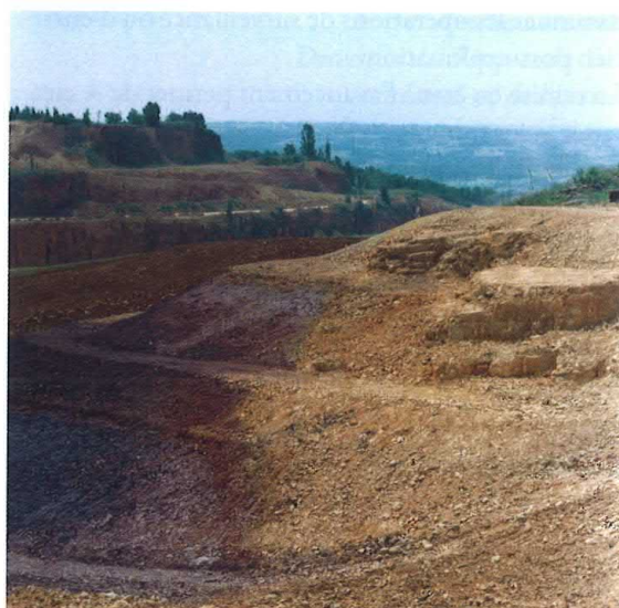
Figure 2 – La préparation des talus par terrassement est un préalable à la végétalisation - Création d'une alternance de milieux entre zones rocheuses et pente douces (Maîtrise d'œuvre Mica Environnement).
