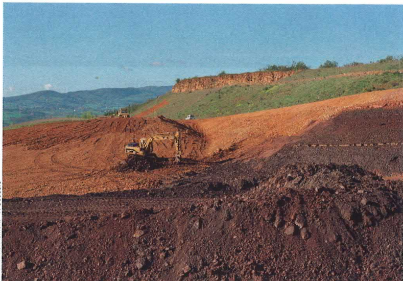
Figure 2 – La préparation des talus par terrassement est un préalable à la végétalisation - Création d'une alternance de milieux entre zones rocheuses et pente douces (Maîtrise d'œuvre Mica Environnement).
