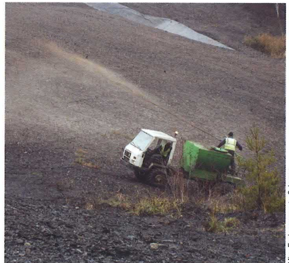
Figure 6 – Hydroseeder 4x4 permettant d'accéder dans les talus (engin Satar).
